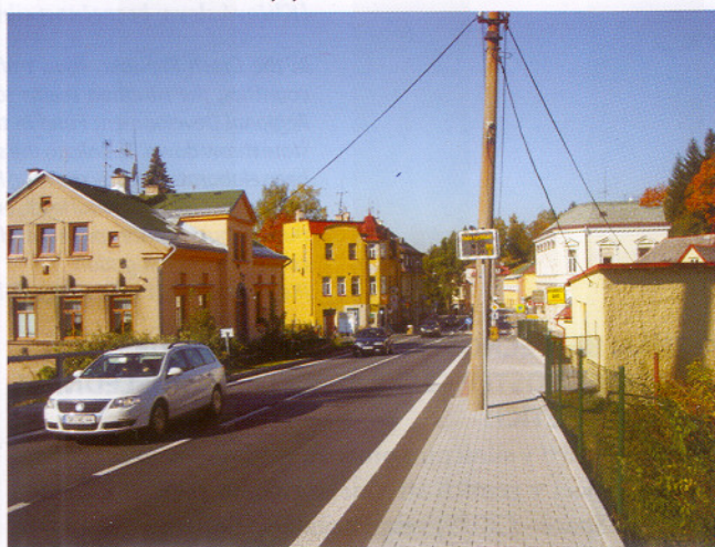
Obr. 2 Informační radar na silnici I/14 v Lučanech nad Nisou byl instalován na základě doporučení předchozích bezpečnostních inspekci
