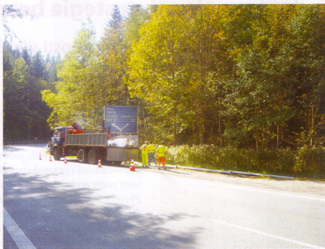
Obr. 1 Montáž svodidel před pevnou překážkou na silnici I/10 (výsledek situační analýzy)
