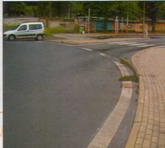
Foto č. 3 - v protisměrném oblouku vznikají úžlabí a je nutné zde zvlášť řešit odvodnění (ne vždy se to povede)
