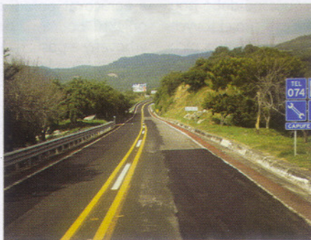
Obrázek 4: Stejná silnice v místě, kde není zpoplatněná. Kvalita povrchu, ale i silničního příslušenství je nižší.
