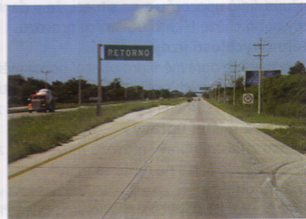
Obrázek 13: Neomezený přístup „nadiavoko“, levé odbočení, sloupky VN v dopravně nebezpečném prostoru.
