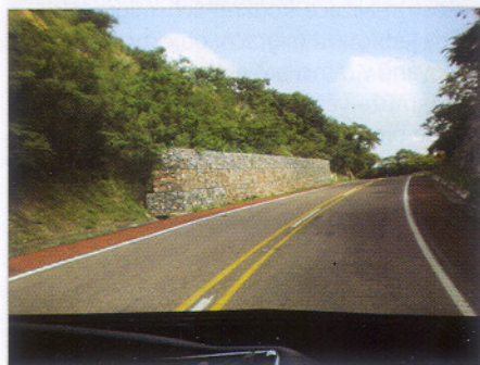
Obrázek 3: Dodatečně doplněná gabionová stěna (již bohužel bez ochrání svodidly).
