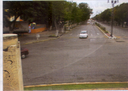
Obrázek 10: Netradiční vyznačení místa pro přecházení šikmo k ose vozovky, směrové šipky „navádějí“ na středový ostrov.
