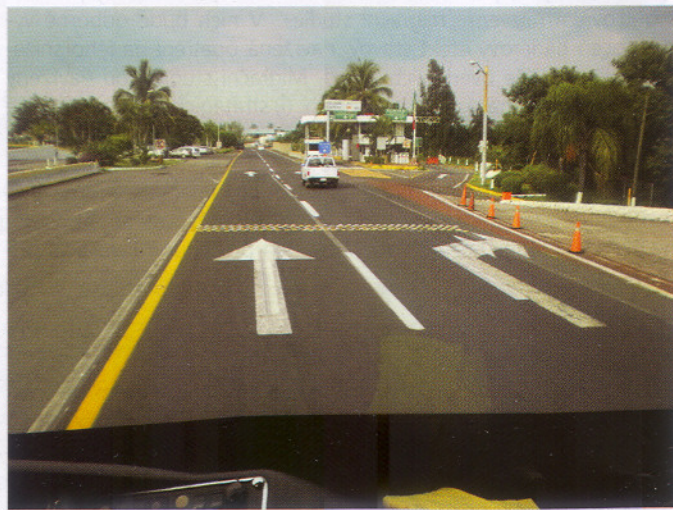
Obrázek 2: „Knoflíkový“ retardér na dálnici. V Mexiku standardní opatření pro snížení rychlosti.
