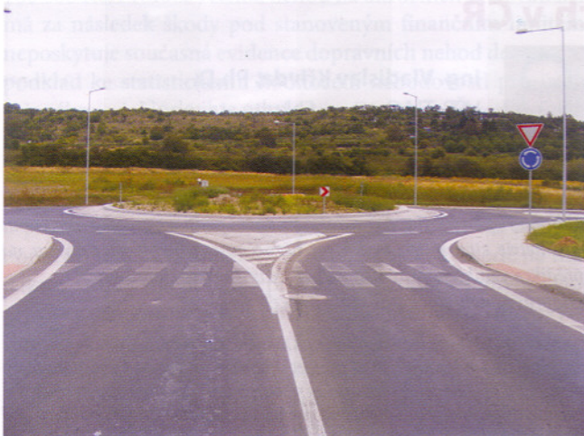
Obr. 2 Nepostřehnutelný dělicí ostrůvek, přechod mimo dělicí ostrůvek
