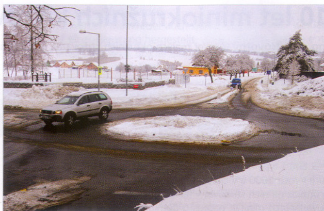
Obrázek 4: Bystřice nad Pernštejnem – Vzorově provedená zimní údržba
