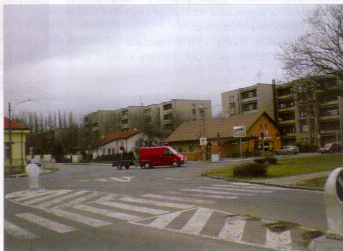
Obrázek 4: Usměrnění vozidel pouze za pomoci vodorovného dopravního značení – nulová boční ochrana přecházejících chodců
