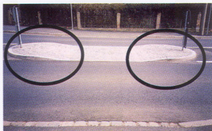
Obr. 5: Chybné provedení snížení obrub dělicího ostrůvku
