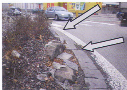
Obr. 2: Litomyšl – vyvrácená obruba ze žulových krajníků
