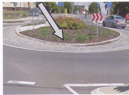
Obr. 7: Optické a funkční deformace středového ostrova
