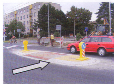
Obr. 8: Pardubice I/36 – Nevhodné provedení ostrůvku řešeného přejížděnými obrubami
