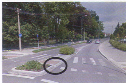
Obr. 6: Pardubice – Ohrazenice, ul. Hradištská - Správné provedení obrub dělicího ostrůvku
