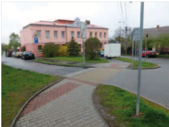
Obrázek 1: Místo pro přecházení – regenerace sídliště Muglinov
