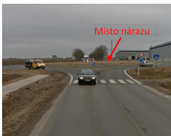
Obr. 10: Silnice II/611 – obsluha logistických center, nedělený přechod v nebezpečné zóně, nekvalitní ostrůvek
