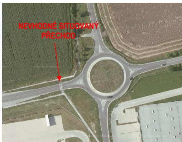
Obr. 9: Silnice II/611 – obsluha logistických center, chybný tvar křižovatky
