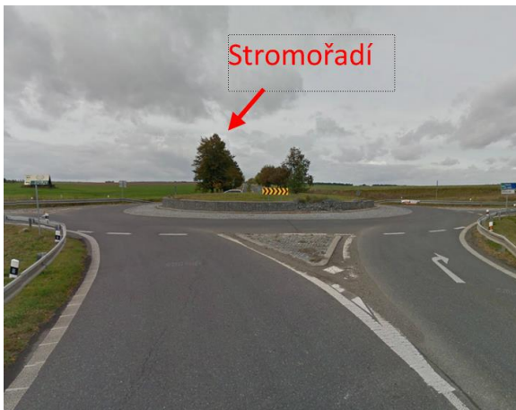
Obr. 5: Vjezd od Jeneče, nevýrazný ostrůvek, chybí C4a
