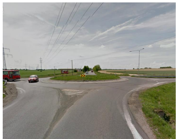
Obr. 7: Silnice II/611 x III/33310 – chybí dělicí ostrůvek na vjezdu, chybí C4a
