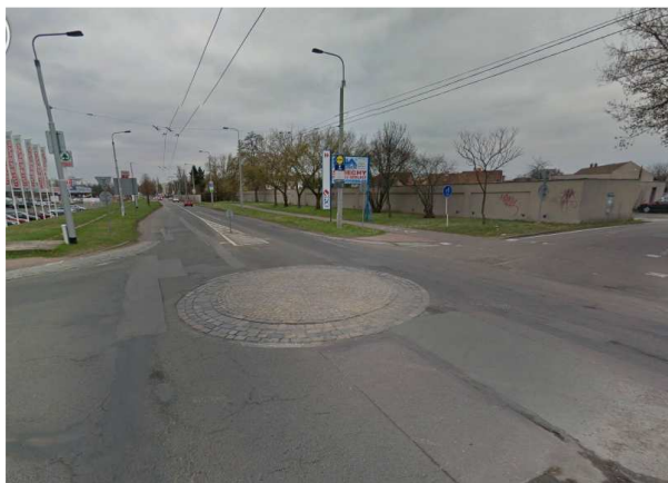
Obr. 13: Stávající stav s nedostatečným VDZ
