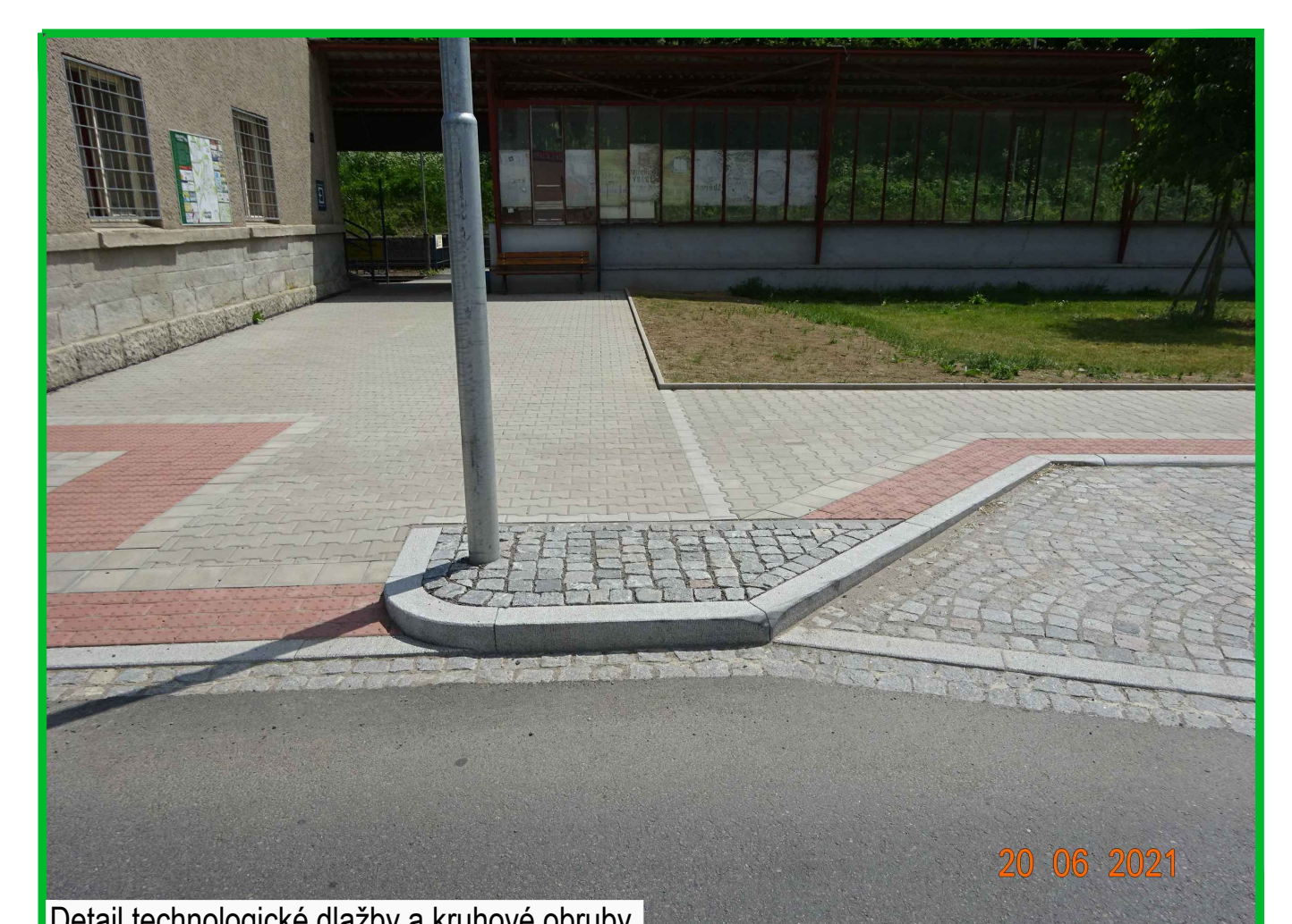
Detail technologické dlažby a kruhové obruby
