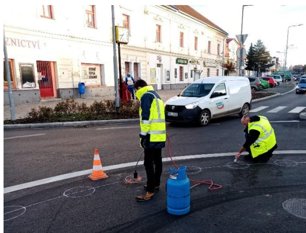
Obr. 3 – Rozměření polohy lepených prvků ve vnějším kruhu.
