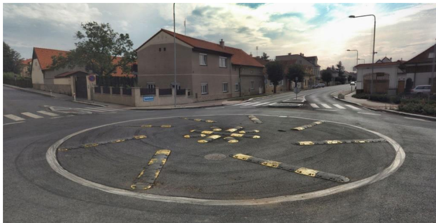
Obr. 1 – Původní řešení středového ostrova pomocí montovaných zpomalovacích prahů.
