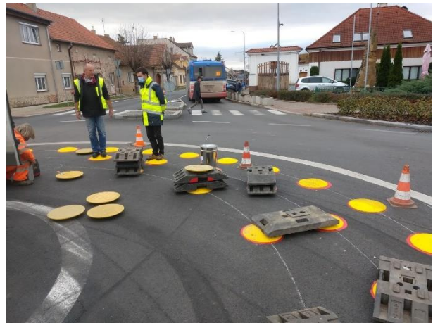
Obr. 6 – Zatěžování přilepených prvků.
