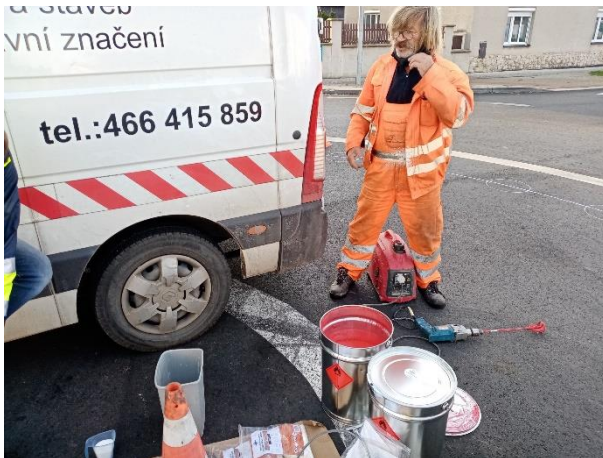
Obr. 5 – Rozmíchání a odvážení lepidla.
