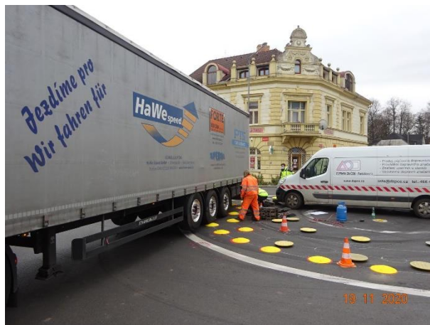
Obr. 9 – Přejezd kamionu cca po 1 hodině od nalepení.
